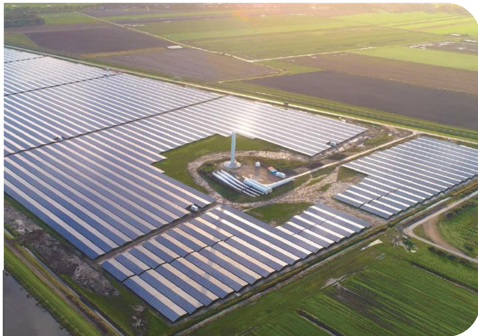
Duurkenakker Solar Power Plant
